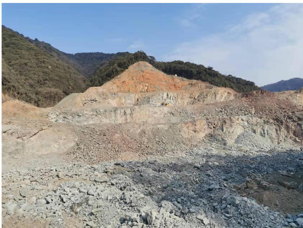
图 2-23 矿区中部形成的边坡台阶
