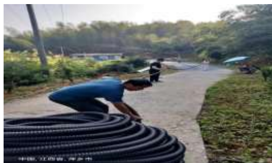
厂区内架空电气线路，距离 57 号、58 号、55 号、54 号等 1.1 级工房安全距离不足（标准要求 35 米），该段电线已改为埋地敷设
