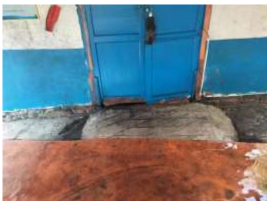
42 号工房、75 号工房及各黑火药库门前有台阶，已设置为防滑坡道
