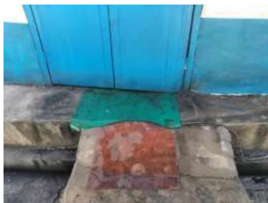
42 号工房、75 号工房及各黑火药库门前有台阶，已设置为防滑坡道
