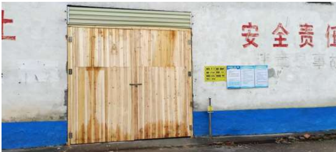
9 号化工原材料库卷闸门已更换为外开门
