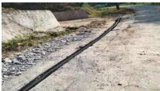
厂区内架空电气线路，距离 57 号、58 号、55 号、54 号等 1.1 级工房安全距离不足（标准要求 35 米），该段电线已改为埋地敷设
