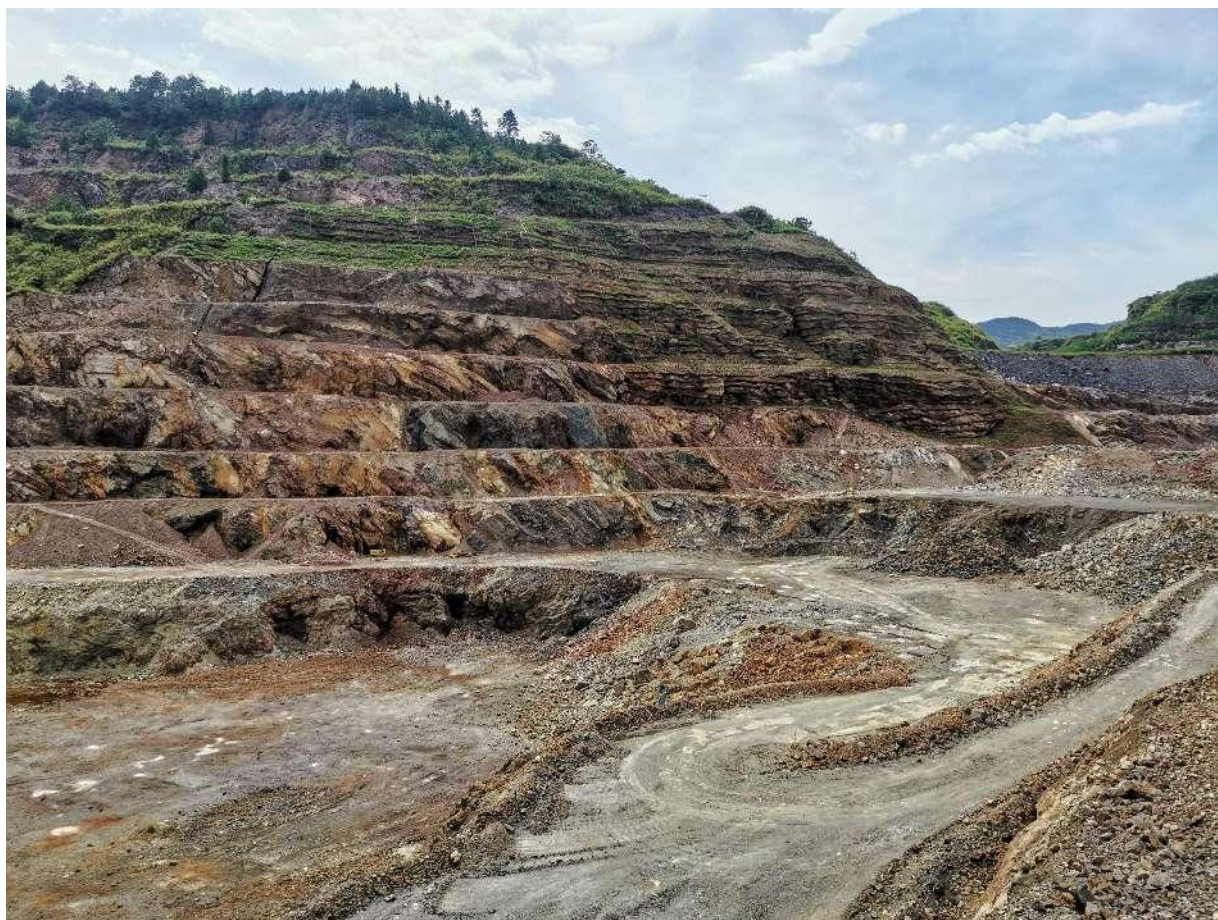
图 4.1-3 南侧边坡现场照片
